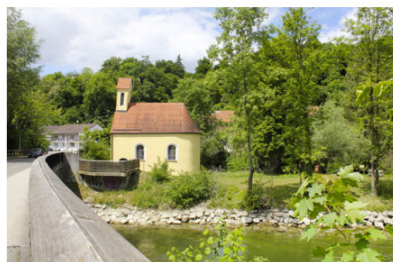
St. Nikolauskapelle an der Amper
